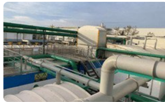
对高新园区污水站恶臭气体进行收集和治理，确保污水站无恶臭气体逸散
